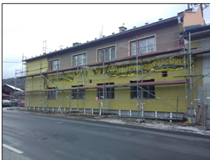
Rekonstrukce KD a hospody
