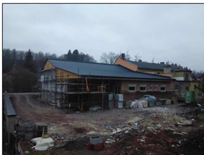
Rekonstrukce KD a hospody
