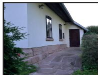
zahradní a podjezdívka po renovaci
