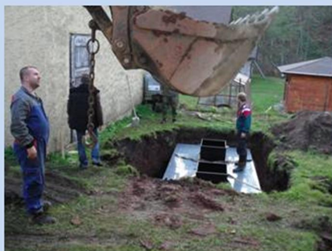
instalace ČOV čp. 37
