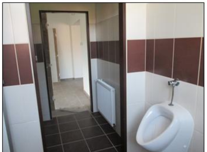
Zrekonstruované soc. zařízení
