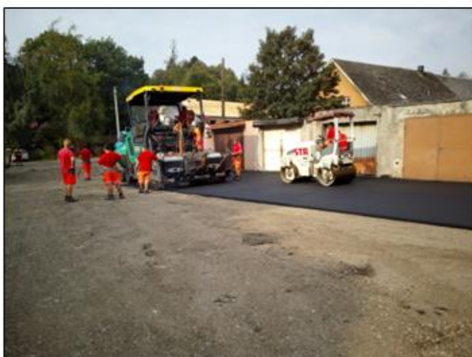
Oprava místních komunikací
