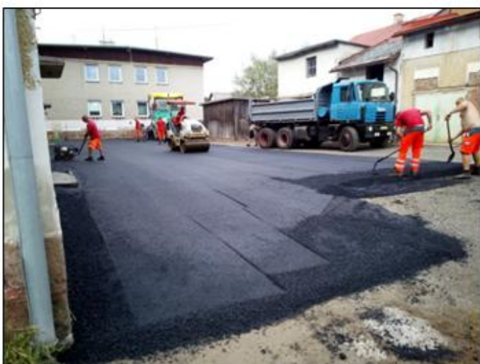
Oprava místních komunikací
