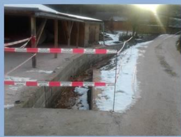
Rekonstrukce po povodních
