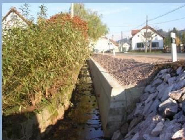
Rekonstrukce po povodních
